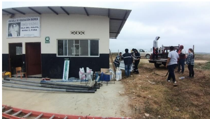
Figura 37. Inicio de instalación de equipos Fuente: Los Autores
