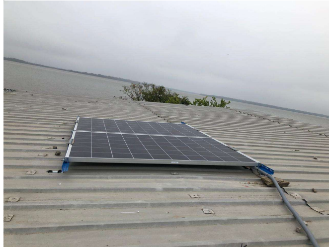
Figura 70. Montaje final del sistema fotovoltaico con paneles solares
