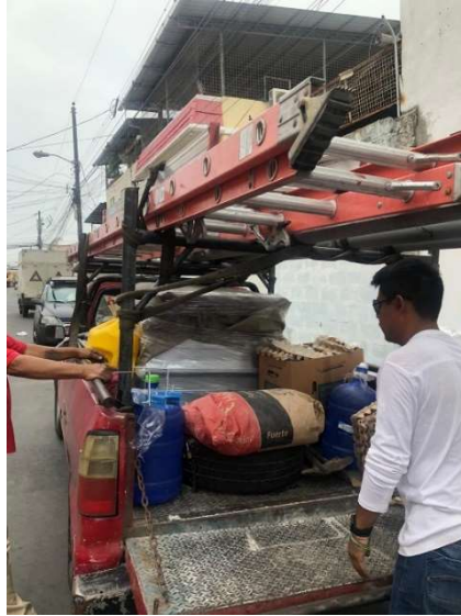
Figura 62. Materiales para el montaje del sistema fotovoltaico con paneles solares
