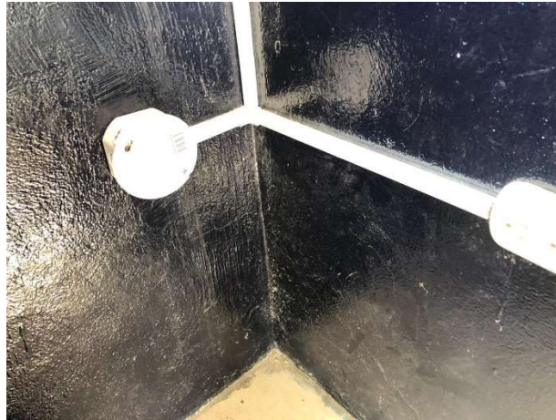
Figura 73. Instalación de cajas de tomacorrientes
