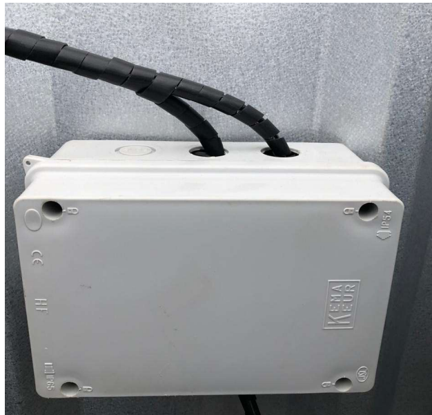
Figura 65. Caja de paso
