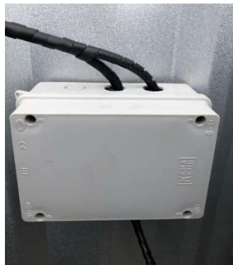
Figura 49. Caja de paso
