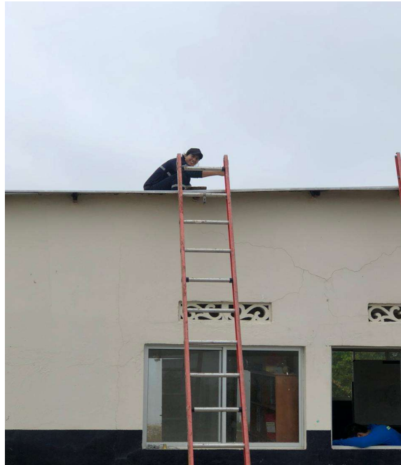
Figura 68. Instalación de paneles solares
