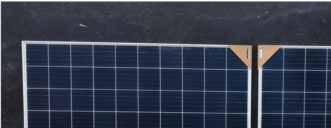
Figura 43. Paneles solares y baterías
