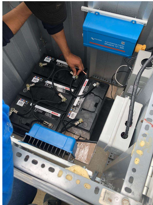
Figura 67. Montaje final del sistema de alimentación.
