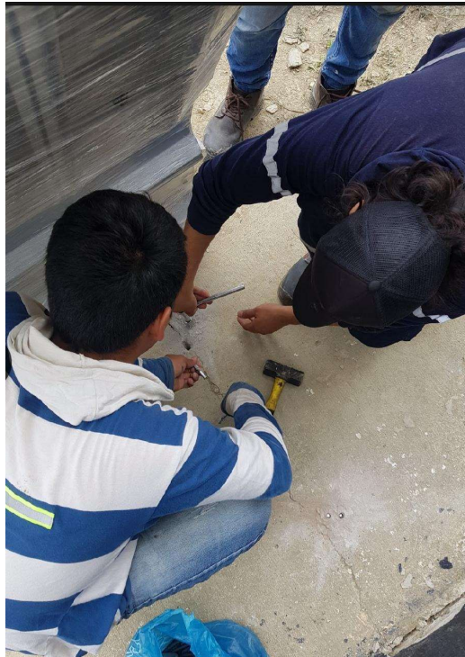
Figura 46. Montaje de base metálica para baterías
