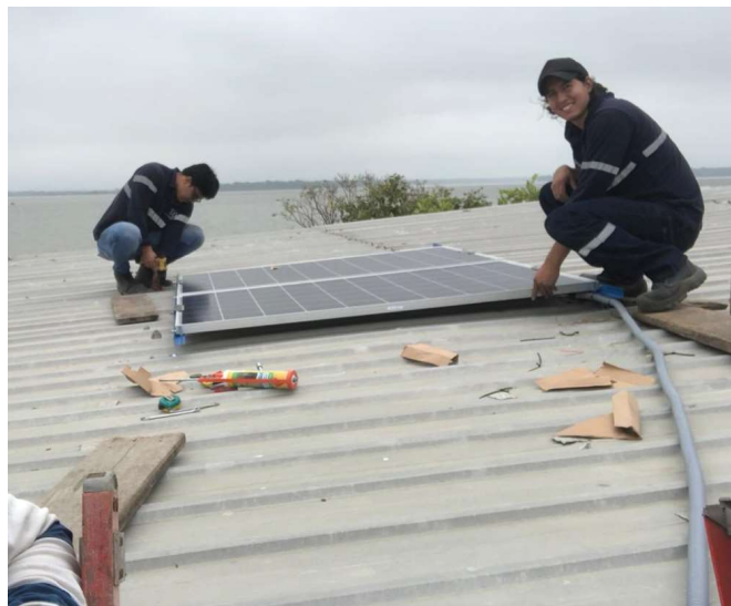
Figura 47. Montaje de paneles fotovoltaicos
