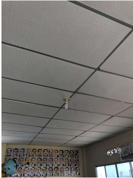
Figura 71. Instalación de Boquilla
