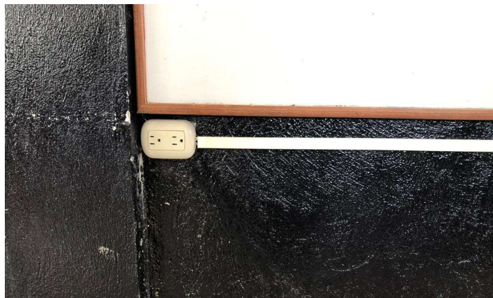
Figura 72. Instalación de tomacorrientes
