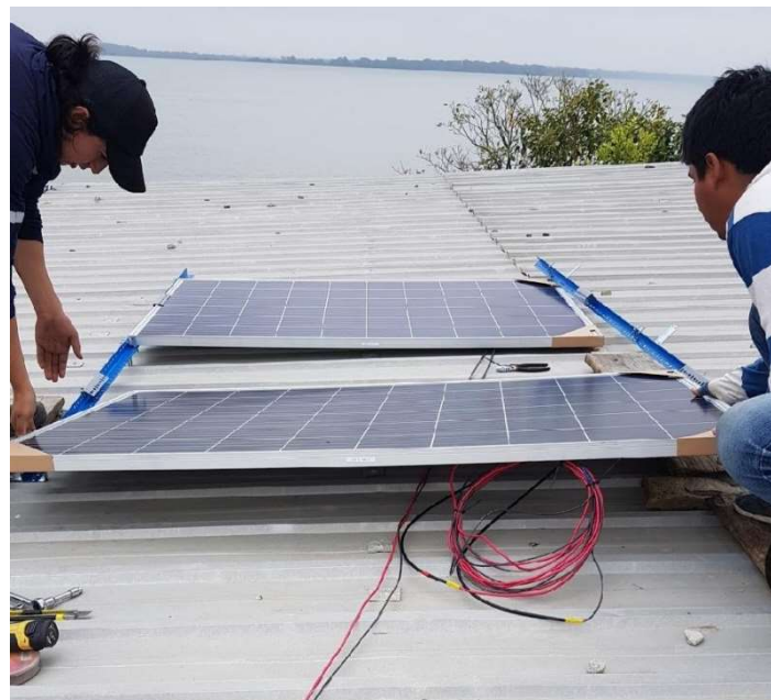
Figura 69. Implementación de paneles solares en casas de la comuna Masa 2
