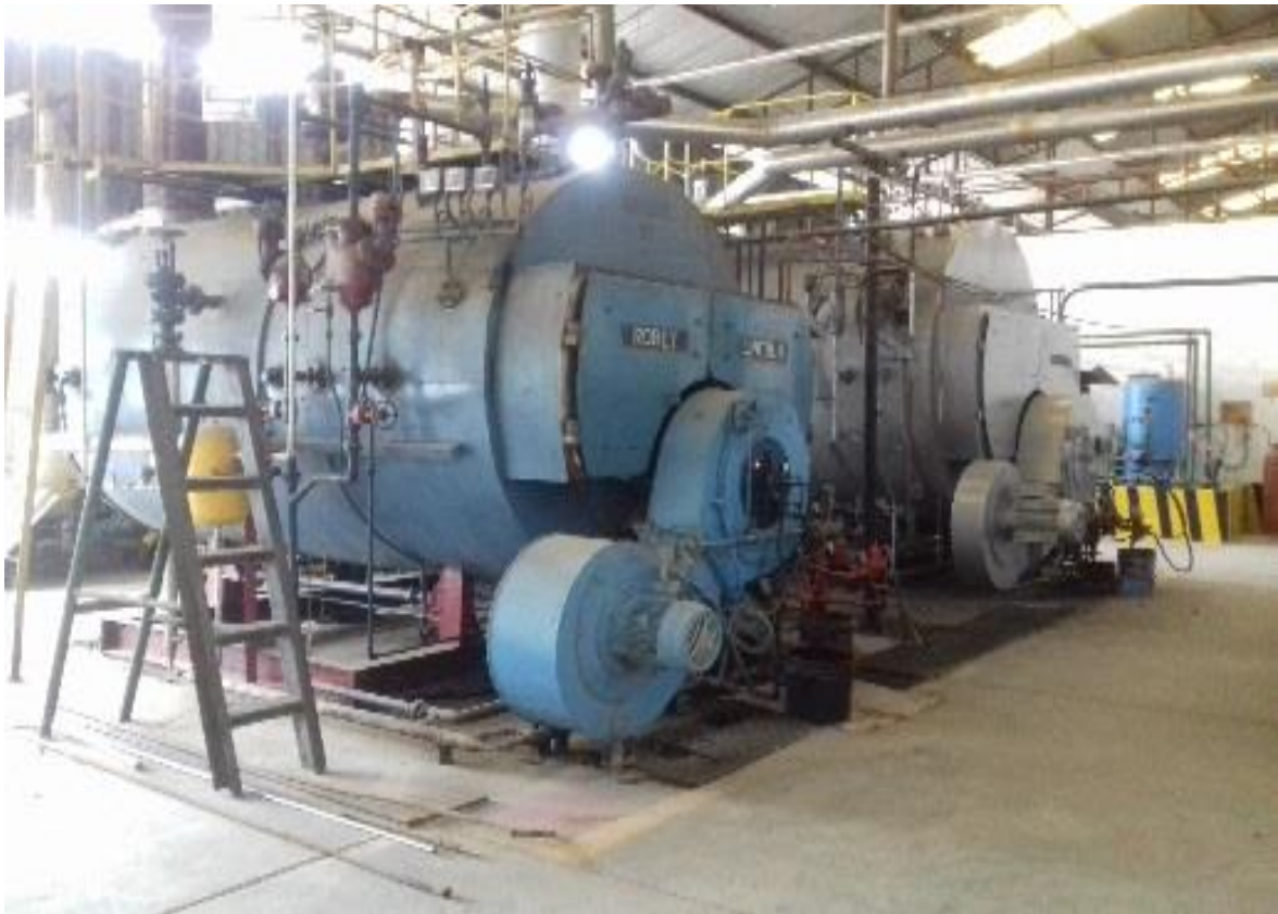
Anexo 12 Maquinaria en buen estado limpias y despejadas.
