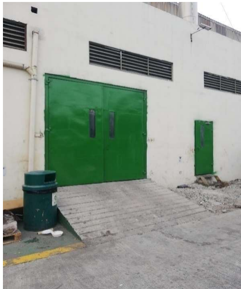
Cierre de Cuarto de Vacío
