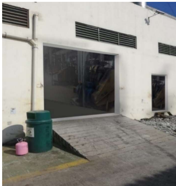
Aberturas en Cuarto de Vacío Fuente: Elaboración Propia
