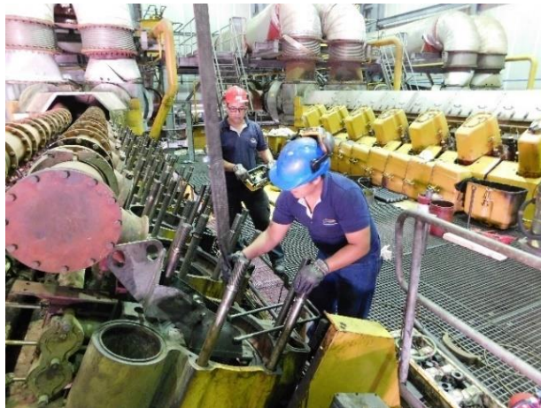
Figura 2.9: Generadores Hyundai de la central Santa Elena 2 [20]
