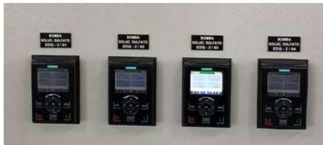
**Ilustración 19.** Paneles de operación IOP-2 correspondientes al proceso de dosificación.
