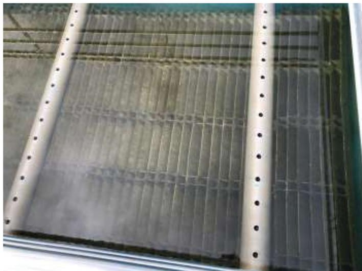
**Ilustración 7.** Decantadores de placas planas paralelas inclinadas de la PTAP Tixán II.
