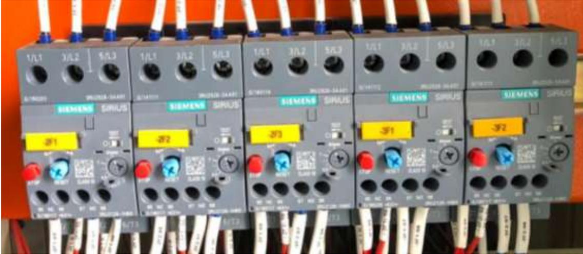
**Ilustración 39.** Relé de sobrecarga térmica Siemens serie 3RU2
