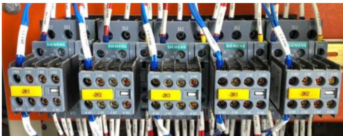
**Ilustración 38.** Contactor Siemens serie 3RT2
