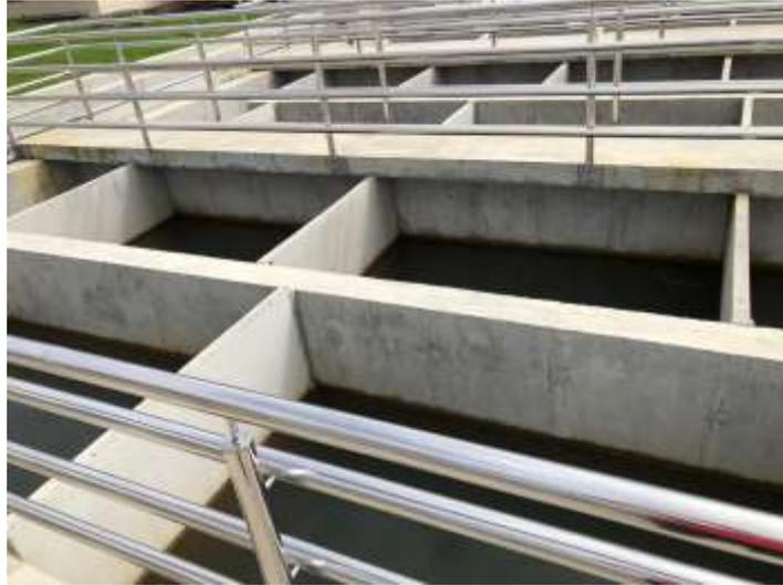
**Ilustración 6.** Floculadores hidráulicos de flujo vertical de la PTAP Tixán II.
