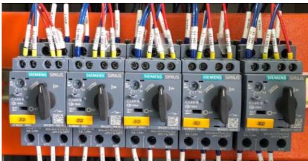
**Ilustración 37.** Interruptor termomagnético automático Siemens serie 3RV2
