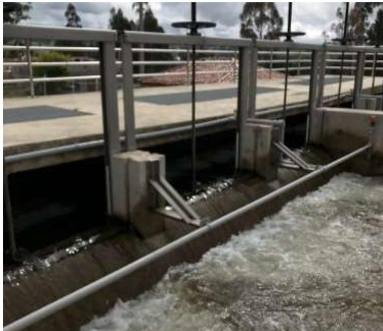
**Ilustración 4.** Tubería de dosificación de Permanganato de Potasio en la PTAP Tixán II.
