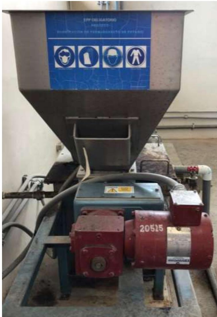
**Ilustración 29.** Motor correspondiente a la dosificación de permanganato de potasio en solución.
