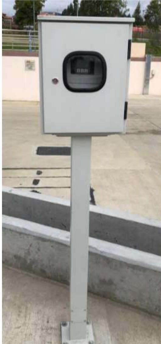
**Ilustración 22.** Pantalla Medidor de caudal Prosonic Flow 93c correspondiente al módulo II de la PTAP.
