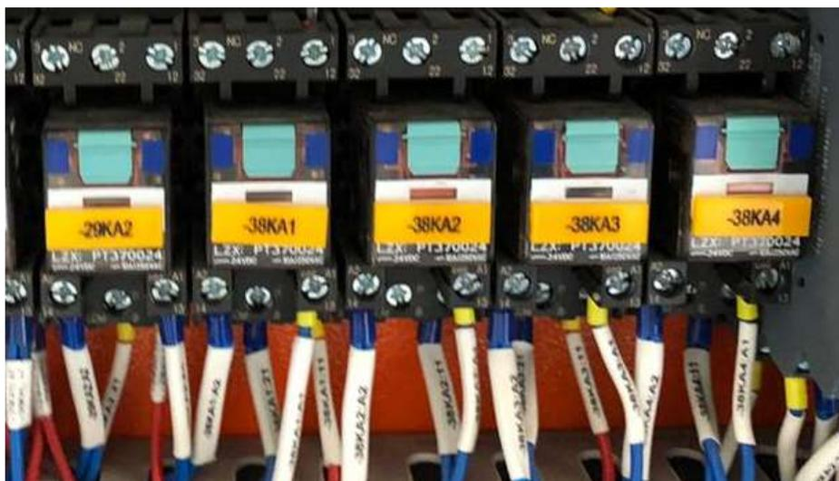
**Ilustración 40.** Relé de propósito general SCHRACK
