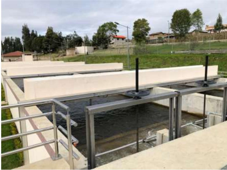
**Ilustración 10.** Tanques de remoción de Manganeseo PTAP Tixán ETAPA EP.
