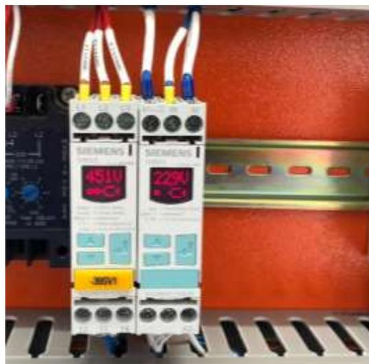
**Ilustración 32.** Supervisor de voltaje electrónico Siemens 3UG4615-1CR20
