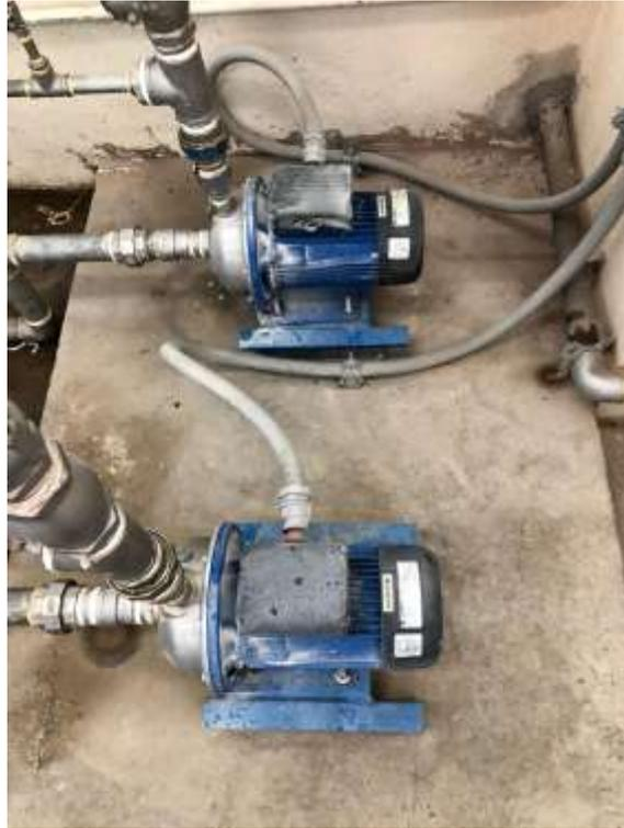
**Ilustración 31.** Bombas centrifugas correspondientes a la etapa de dosificación.
