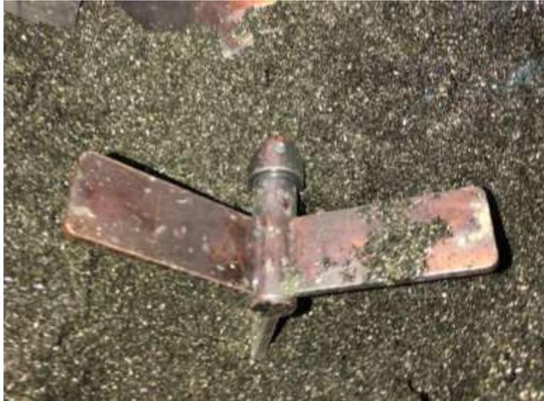
**Ilustración 27.** Interruptor de nivel bajo tipo paletas rotativas en la tolva de permanganato de potasio granulado.
