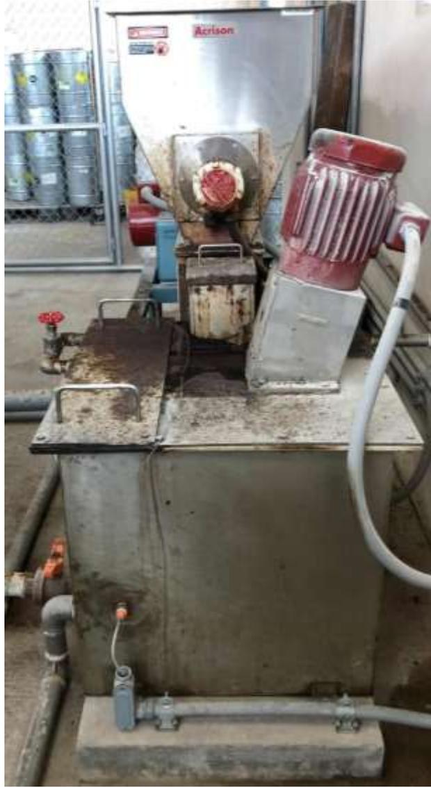
**Ilustración 30.** Motor de agitación en la cuba de permanganato de potasio en solución.
