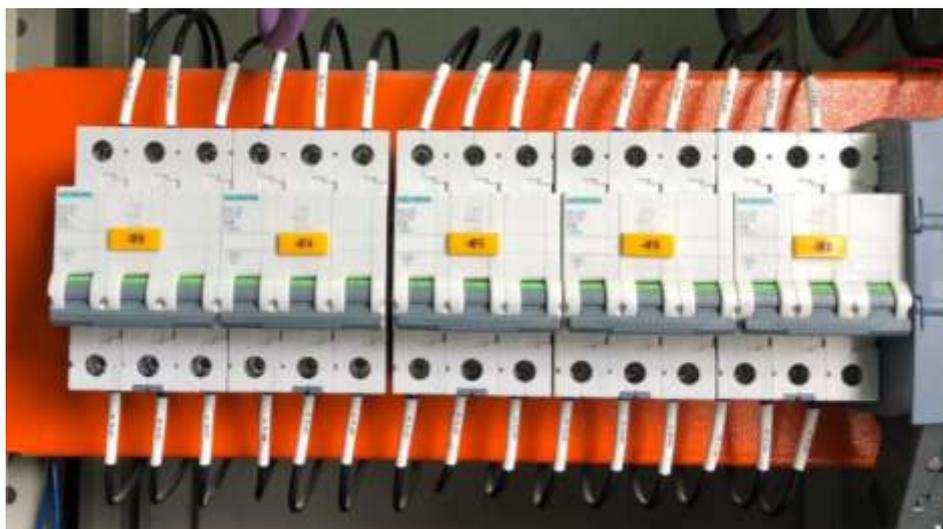
**Ilustración 36.** Interruptor termomagnético automático Siemens serie 5SL
