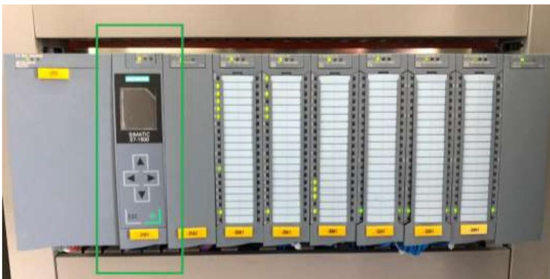
**Ilustración 12.** Autómata Programable S7-1500 del tablero de control Tc-Mn.
