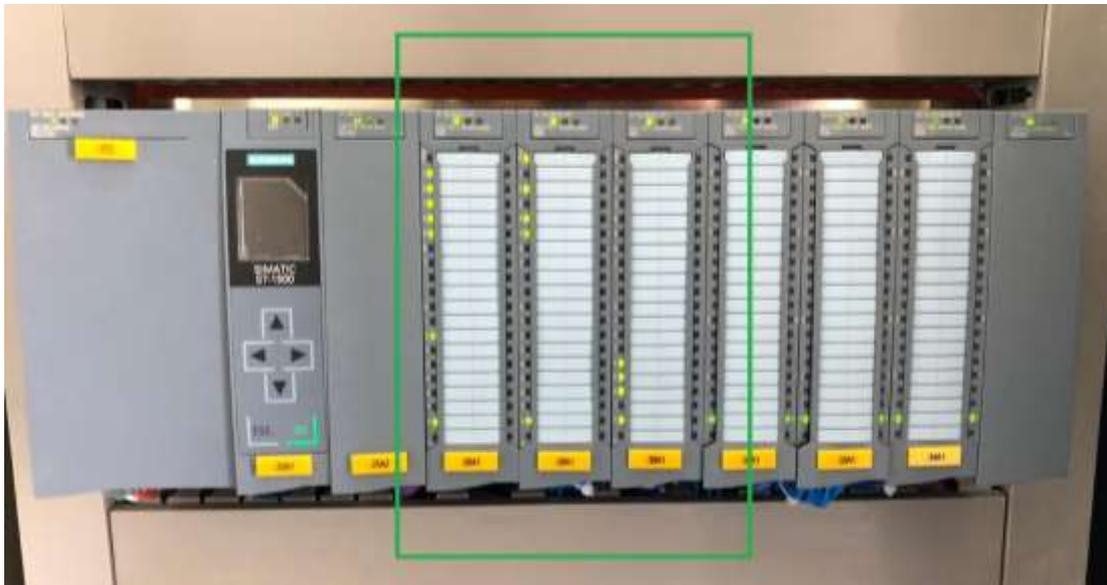
**Ilustración 14.** Módulos de entradas digitales conectado al PLC del tablero TC-Mn
