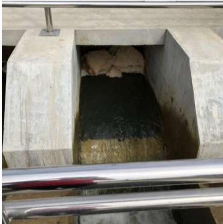
**Ilustración 5.** Canal de mezcla rápida en la PTAP Tixán II.
