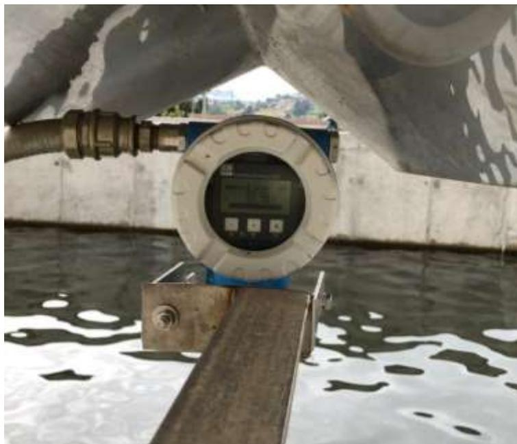
**Ilustración 24.** Sensor de nivel Prosonic Flow 93c correspondiente al tanque este.
