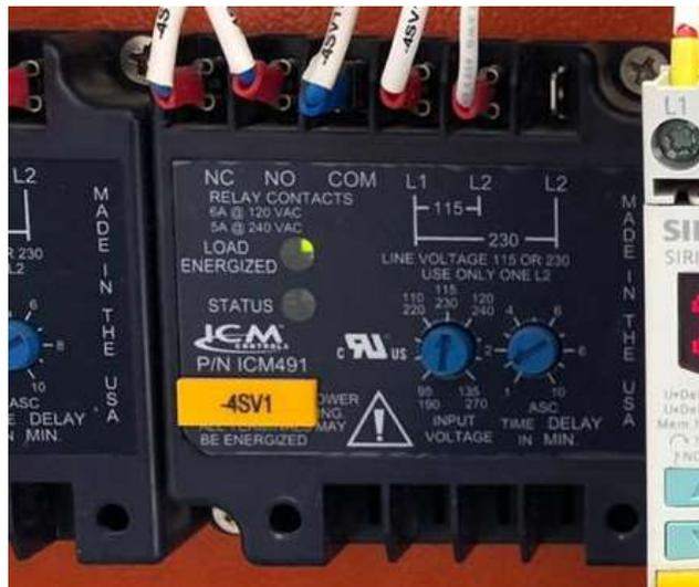
**Ilustración 33.** Monitor de línea Monofásico ICM – 491
