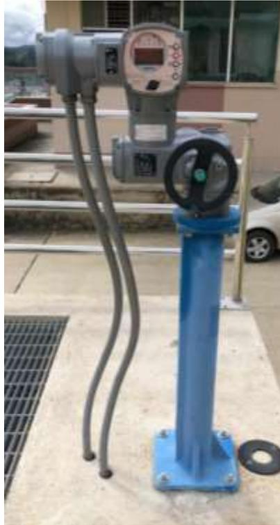
**Ilustración 21.** Actuador Auma 01.2 correspondiente a la salida al módulo I.
