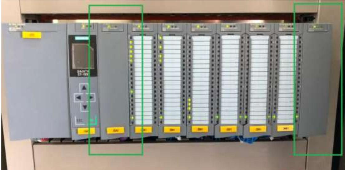
**Ilustración 13.** Módulo de comunicación Profibus DP del tablero TC-Mn
