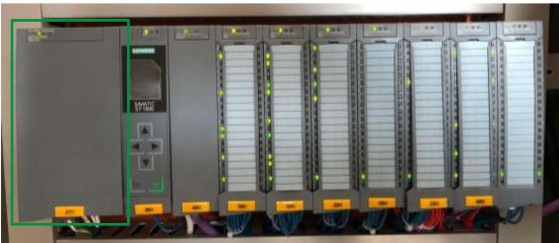
**Ilustración 34.** Fuente de alimentación estabilizada Siemens 6EP1333-4BA00
