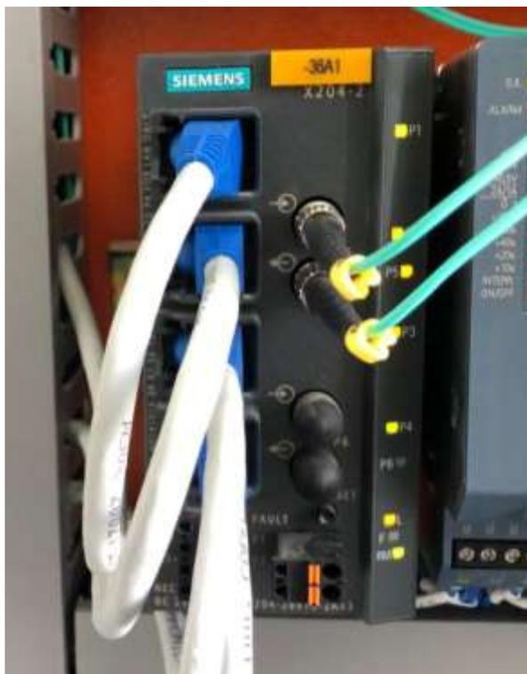
**Ilustración 20.** Switch Siemens SCALANCE X204-2 correspondiente al tablero de control TC-Mn
