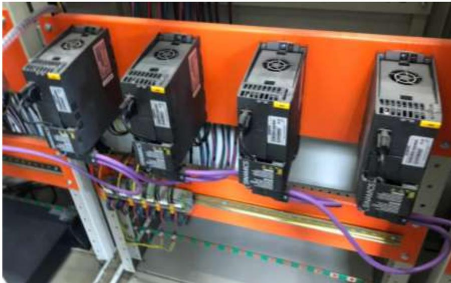
**Ilustración 17.** Variadores de velocidad del tablero TC-Do
