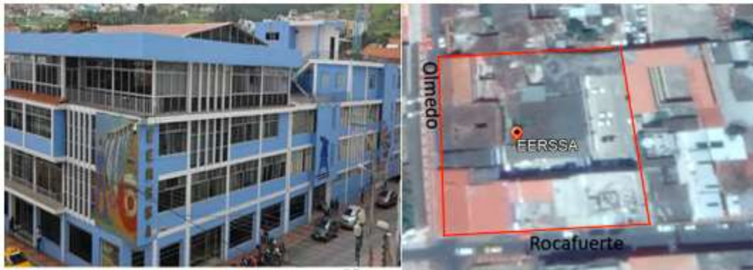
Figura 11. Ubicación edificio principal de la Empresa Eléctrica Regional del Sur S.A. Fuente: Autores.
