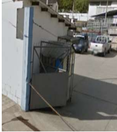
Figura 16. Infraestructura para el servicio de seguridad.
