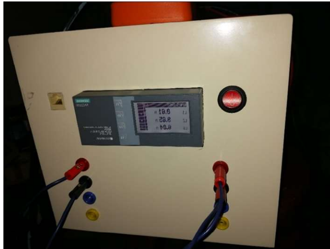
FIGURA 24: Elaboración de estructura metalmecánica para medidor de parámetros SENTRON PAC 2200. Fuente: Los autores
