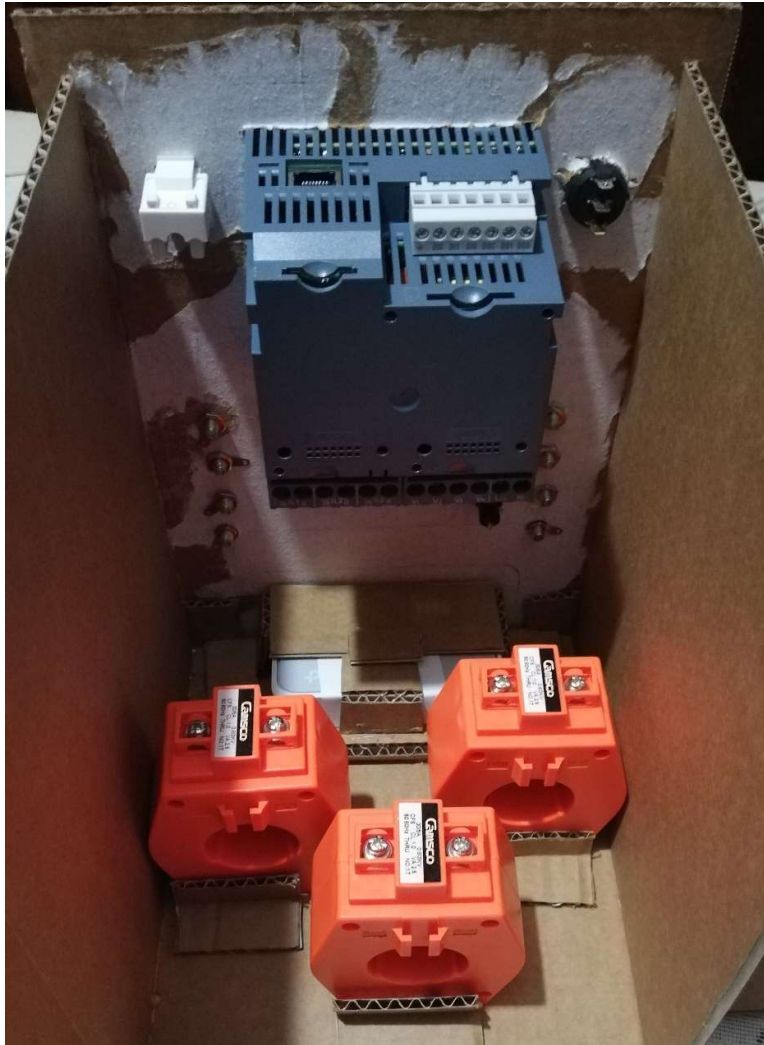
FIGURA 18: Adecuación de espacio para transformadores de corriente de medición. Fuente: Los autores. [19]
