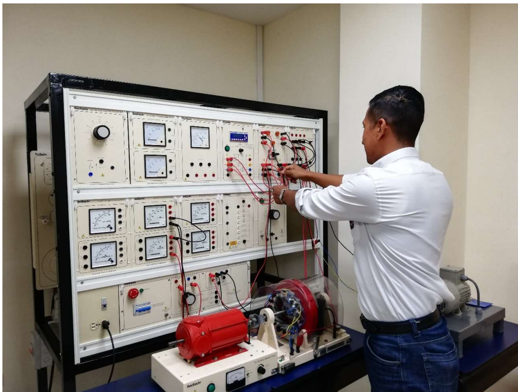
FIGURA 20: Medición y registro de valores en tablero existente. Fuente: Los autores. [3]
