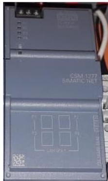
Figura 20. Switch CSM 1277
