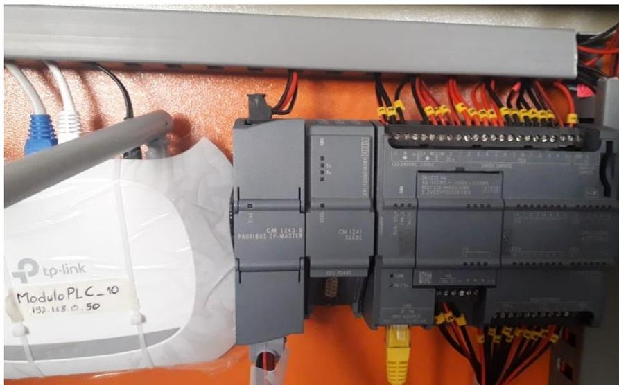
Figura 59. Implementación del módulo CM 1243-5 Maestro PROFIBUS
