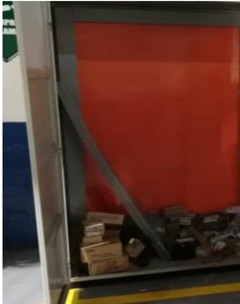
Figura 88. Previo al montaje de componentes en el tablero de control
