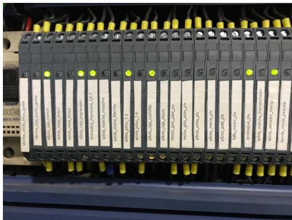
Figura 92. Identificación de salidas del relay de estado sólido
