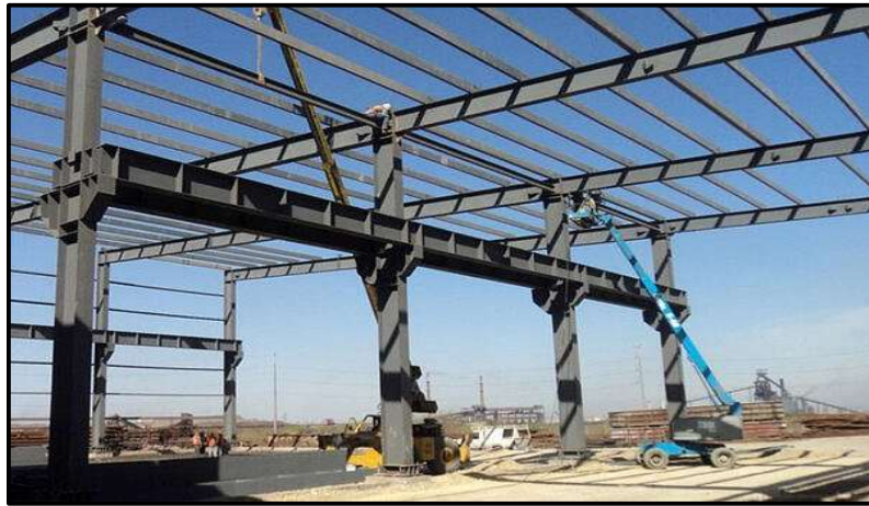
Figura 2.1 Edificio con estructura de acero Fuente: Empresa Laminas y Aceros
