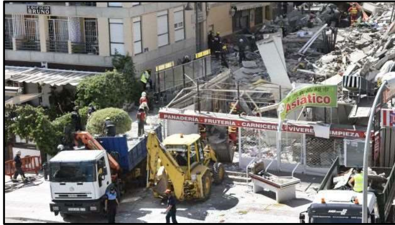
Figura 2.7 Colapsó un edificio en una zona residencial en abril. Fuente: Getty
