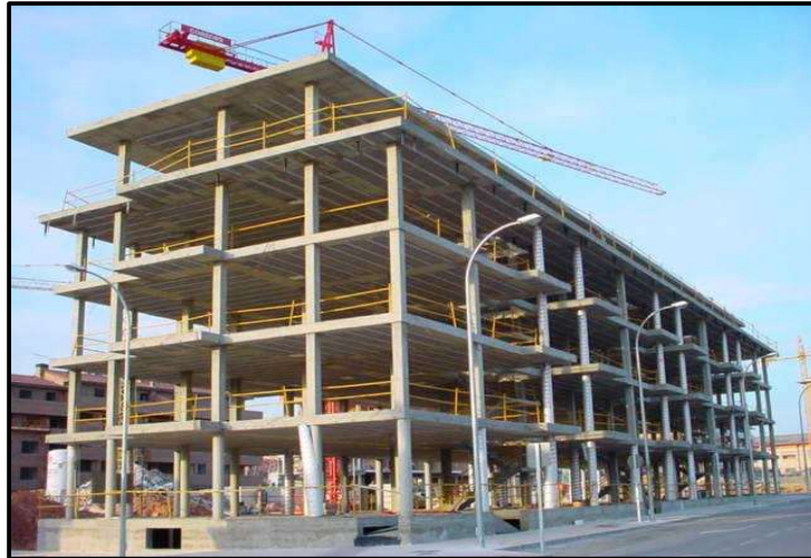
Figura 2.2 Edificio con estructura de concreto Fuente: Blog MOSIngenieros
