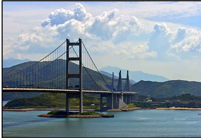
Figura 2.12 Puente Tsing Ma de Hong Kong Fuente: Megaconstrucciones.net
