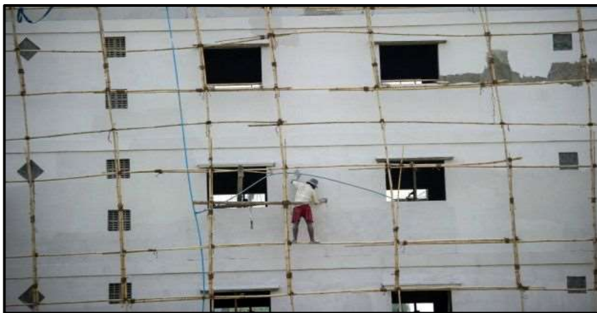
Figura 2.9 Uso de andamios de bambú en construcciones a gran escala Fuente: Getty
