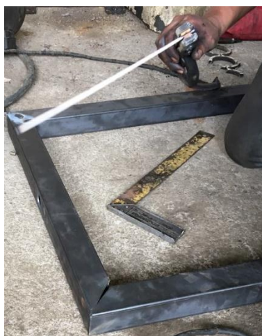
Figura 42. Unión de la Estructura.
