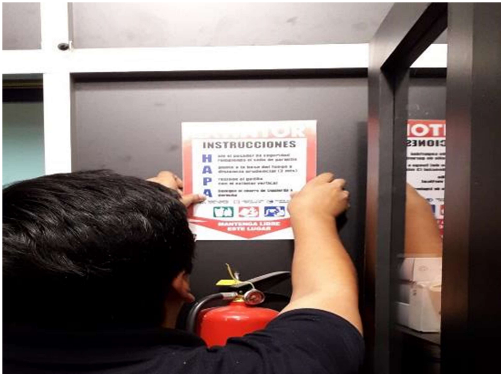
Instalación de señalética HAPA de extintor.
