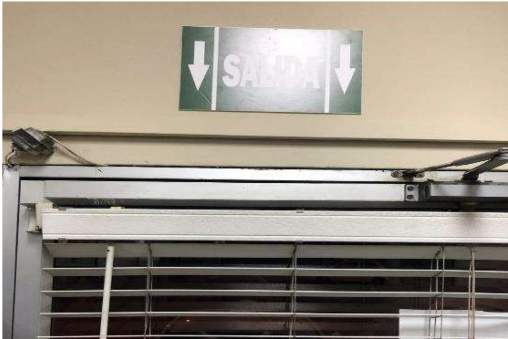
Instalación de señalética de salida.
