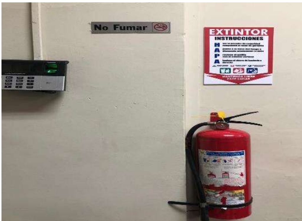
Instalación de señalética HAPA de extintor y de no fumar.
