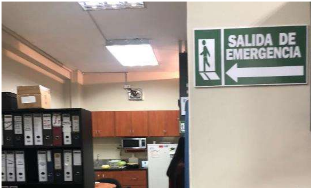
Instalación de señalética de salida de emergencia.
