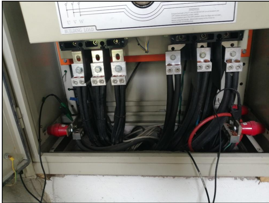
Anexo 4.2. Puesta a tierra y neutro del ATS.
