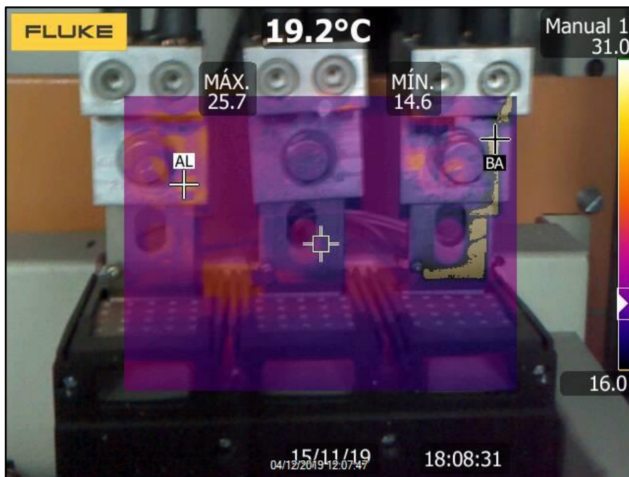
Anexo 4.9. Análisis térmico salida del ATS al bloque "G".
