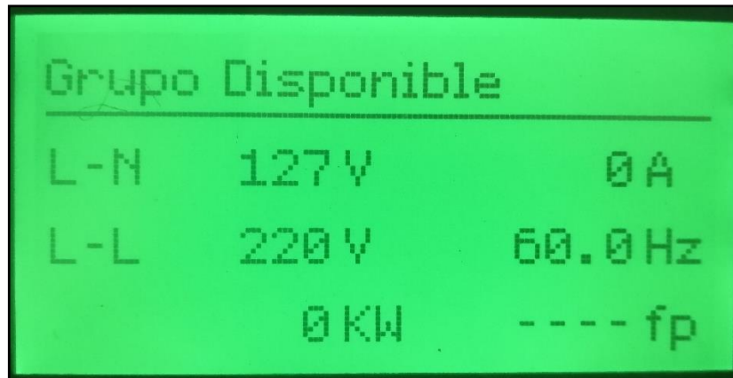
Anexo 3.2. Datos del generador de V,I
