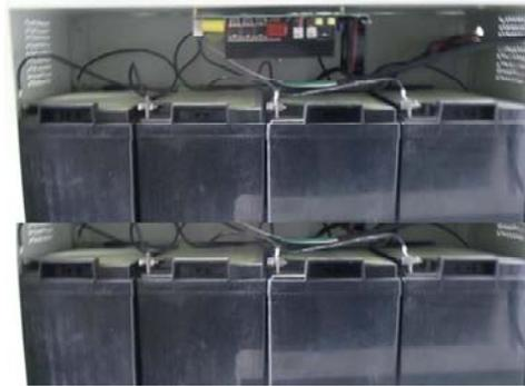
**Figura 2.13:** Banco de baterías instalado en el Nodo de Barabón.
