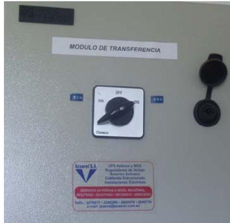
**Figura 2.6:** Modulo de transferencia manual
