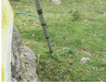
*Figura 1.16: Conexión de Tierra*
