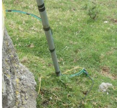
*Figura 2.10: Sistema de Puesta a tierra en el Nodo de Barabón.*
