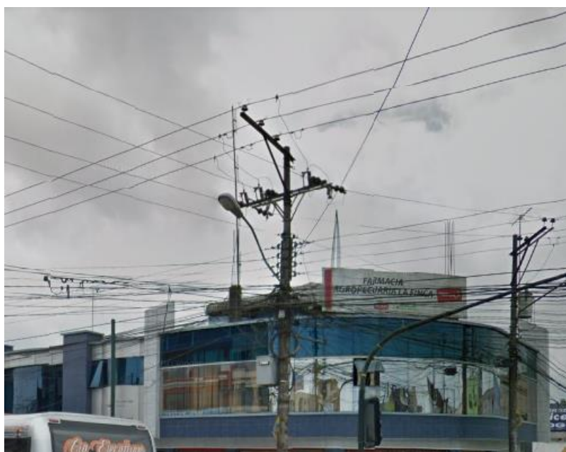
Figura 2. Red de Medio Voltaje en la Zona de Estudio Elaborado por: Víctor Hugo Villavicencio Redrobán
