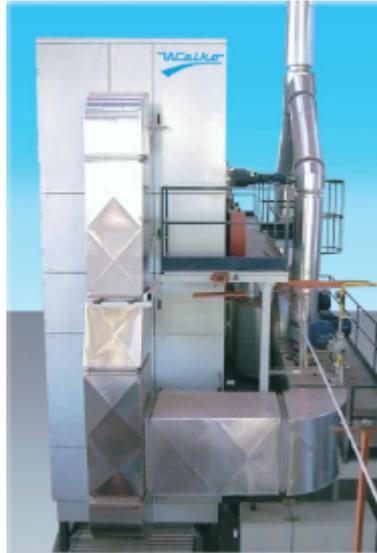
Figura 1.7: Secador Vertical del Fabricante Italiano Welko
