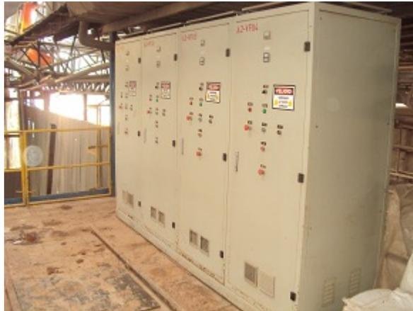
Figura 4.23: Armarios que contienen los variadores de Frecuencia.
