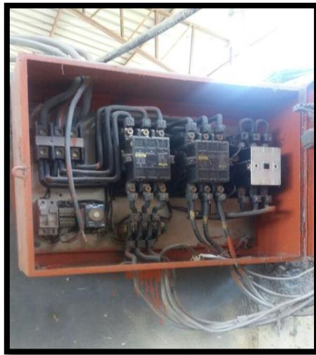
*Figura 19.* Tablero de Fuerza de la línea de corte.
