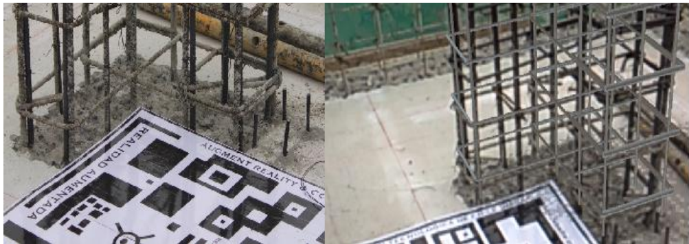
Figura 5.40 AR para estructuras de construcción
