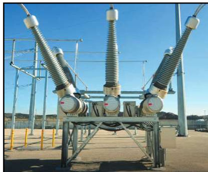
FIGURA 19: INTERRUPTOR TANQUE MUERTO [12]
