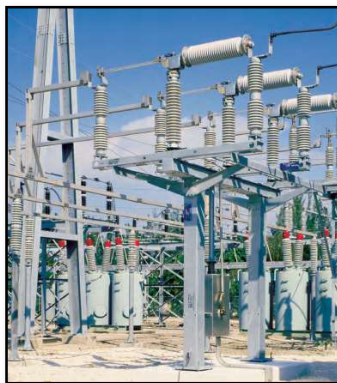
FIGURA 21 SECCIONADOR [15]
