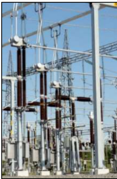
FIGURA 25 SECCIONADOR TIPO PANTÓGRAFO [16]
