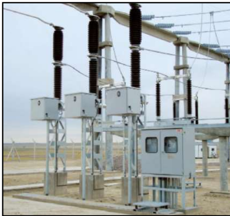
FIGURA 24 SECCIONADOR DE COLUMNAS GIRATORIAS [17]
