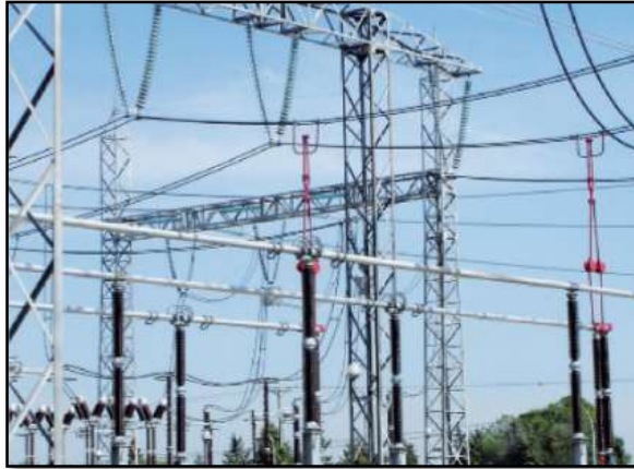
FIGURA 26 SECCIONADOR TIPO RODILLA [16]
