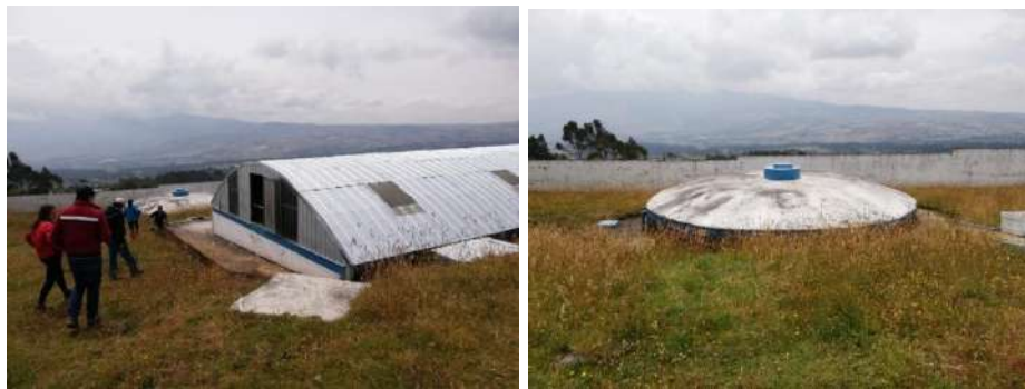
Fotografía 2. Planta de tratamiento y Tanque de distribución – Umbría. Elaborado por: Autores.
