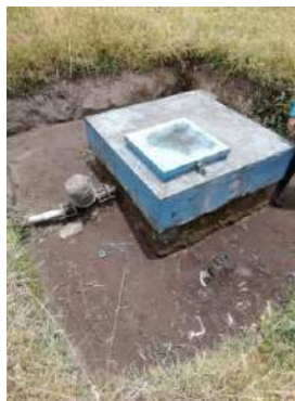
Fotografía 1. Tanque rompe presión en la línea de distribución de agua hacia los barrios. Elaborado por: Autores.
