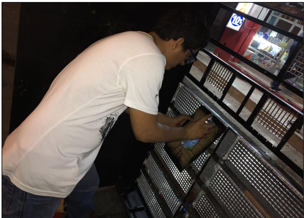
Figura 89- Pintado de la estructura del visualizador
