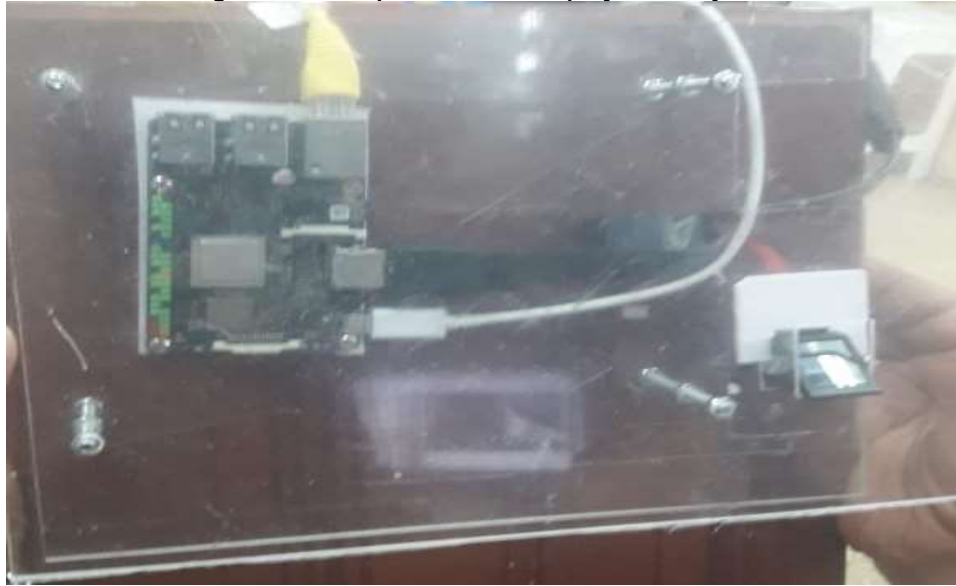
Figura A.18 Montaje de la tarjeta Asus al Tablero del prototipo de marcación Fuente: Los Autores
