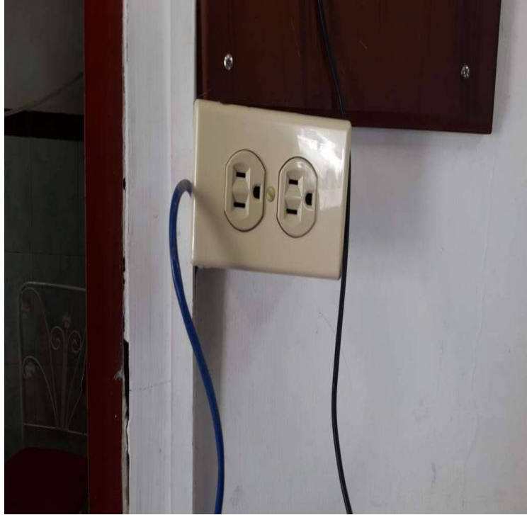
Figura A.20 Instalación de un tomacorriente para el encendido del prototipo de marcación . Fuente: Los Autores
