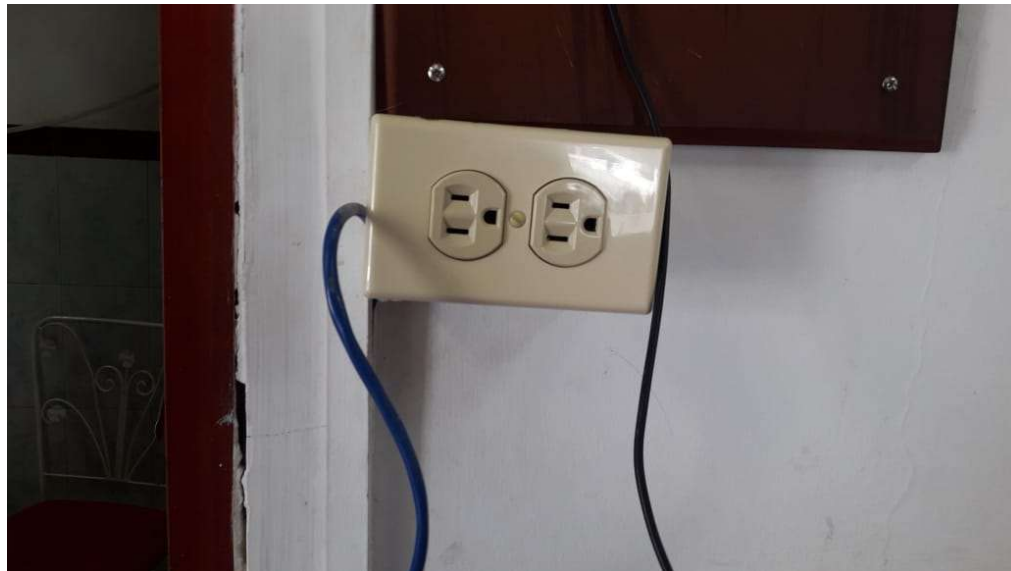
Figura 4.4 Instalación de un tomacorriente para el encendido del prototipo de marcación Fuente: Los autores
