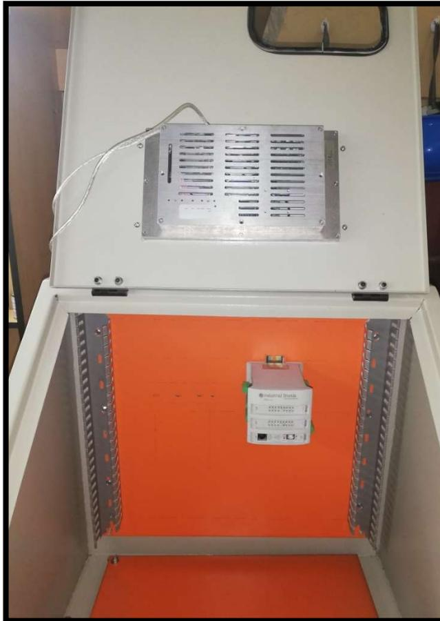
Figura 3.5: Instalación de canaletas y módulos programables.
