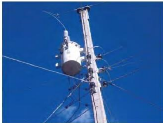
Figura 2.1 Centro de transformación para usuarios finales 22 .
