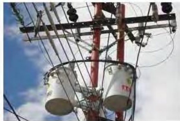
Figura 1.8 Transformadores de Distribución 11 .
