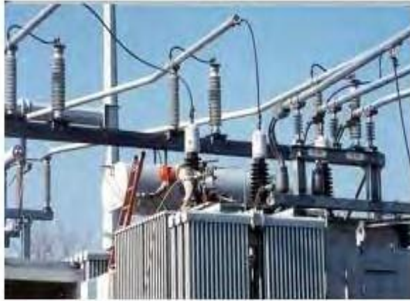
Figura 1.7 Subestación de Distribución 10 .
