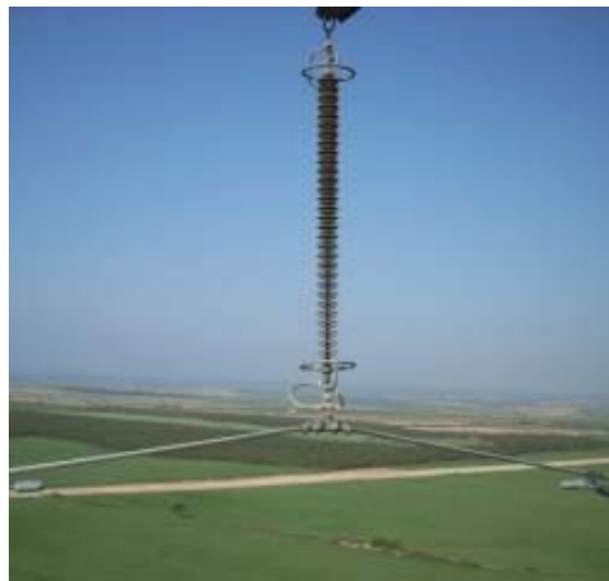
FIGURA 23. Cadena de suspensión
