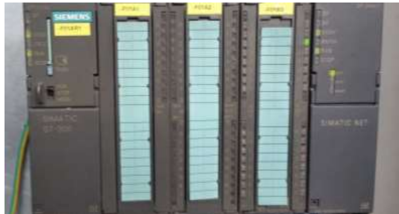
Figura 3.7 Interfaz del CPU 313C
