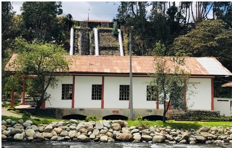
Figura 1.1 Planta Eléctrica Yanuncay 2019. Fuente: Autores.
