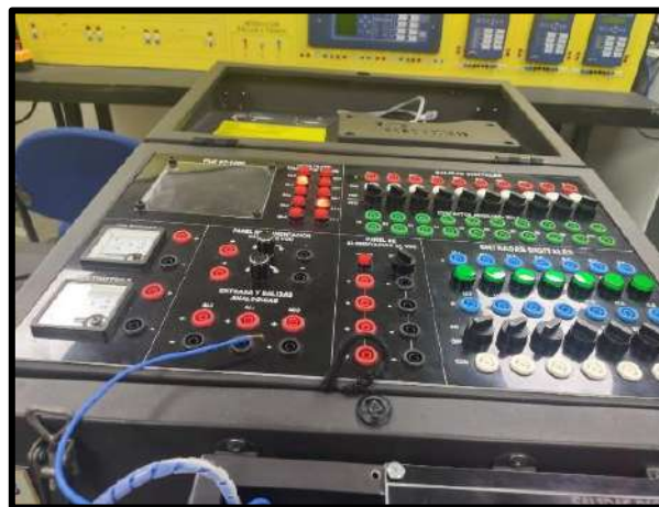
Ilustración 67: Falla por obstrucción de sensores PLC S7-1200 y Logo
