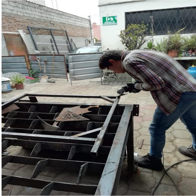
Pulida de suelda de estructura
