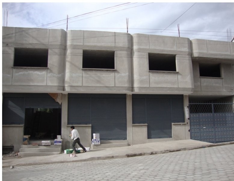
IMAGEN N° 2 AVANCE ESTRUCTURA FÍSICA PROYECTO
