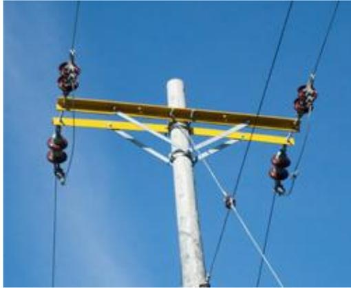
Figura 1.1 Cruceta instalada en línea de alta tensión.
