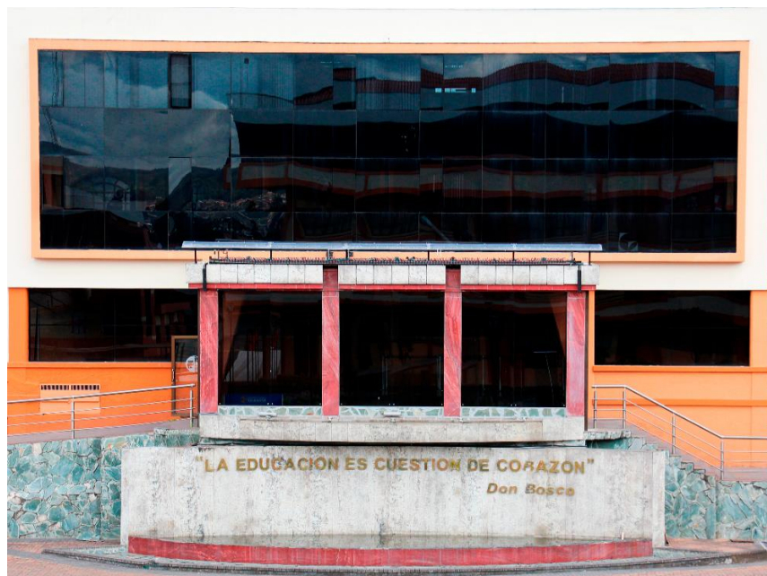
Figura 3.3 Detalle de la fachada de la superficie seleccionada para la propuesta. Fuente: [Autores]
