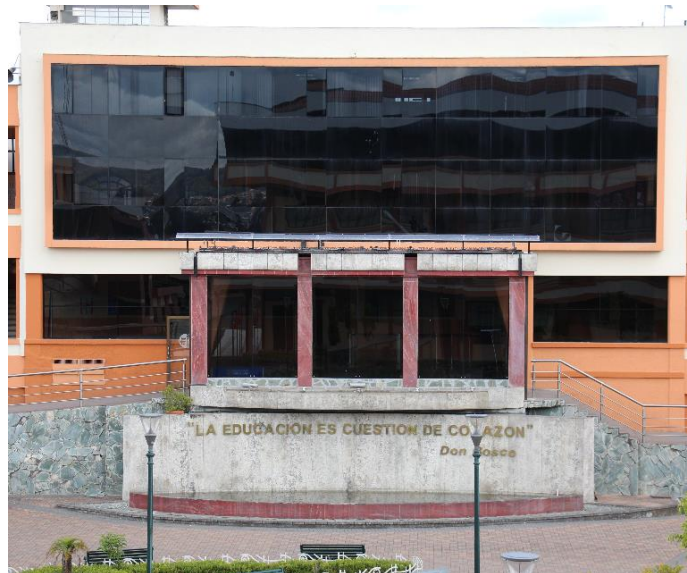
Figura 2.1 Vista frontal del edificio Cornelio Merchán desde el punto de proyección Fuente: [Autores]
