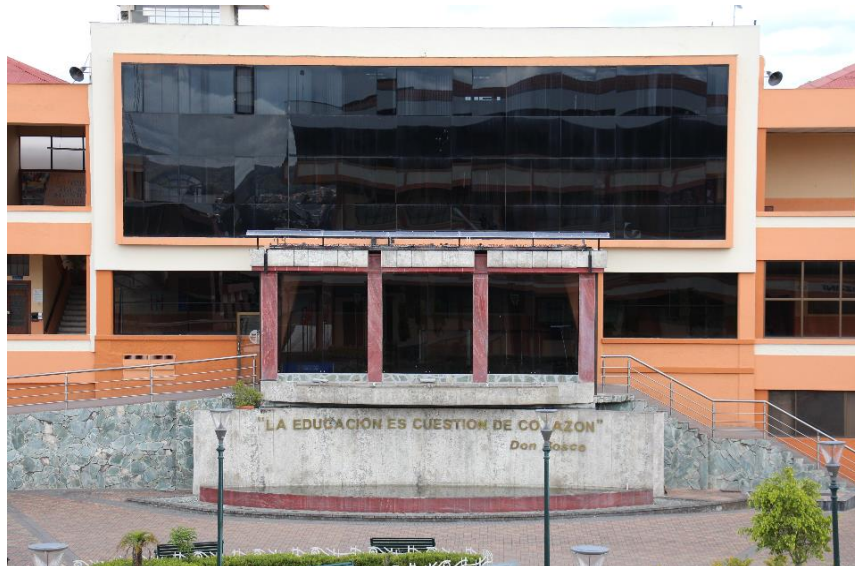
Figura 3.2 Vista frontal del edificio Cornelio Merchán Fuente: [Autores]
