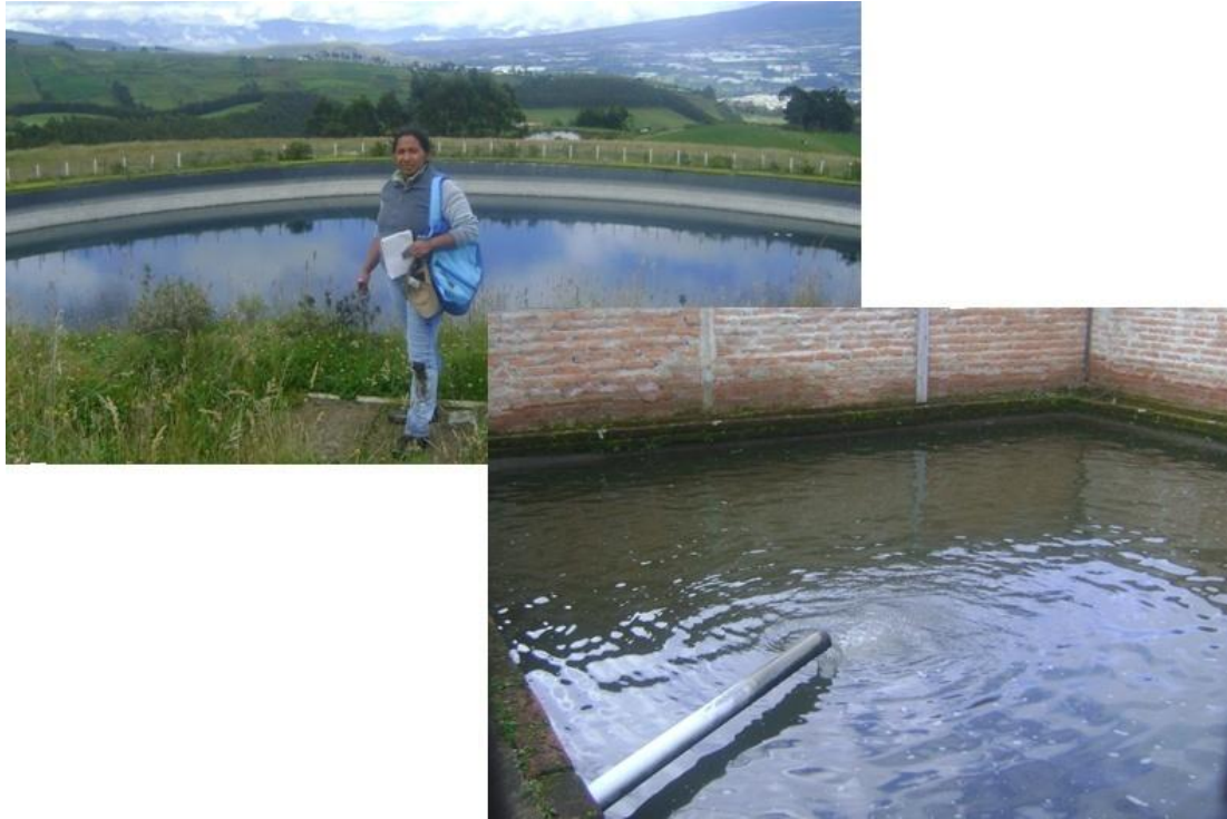
FOTO 4. Reservorios, en el balance hídrico para riego en la microcuenca del río Blanco. Cayambe – Ecuador. 2009.
