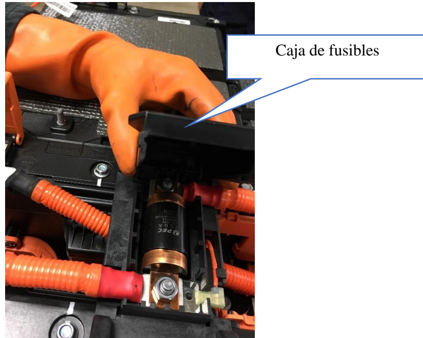
Figura 48. Desmontaje caja de fusibles. Fuente: Autores.
