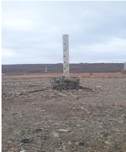
**Fotografía 2. 5** *Ducto de salida de gases en una terraza ya terminada. Elaboración propia*
