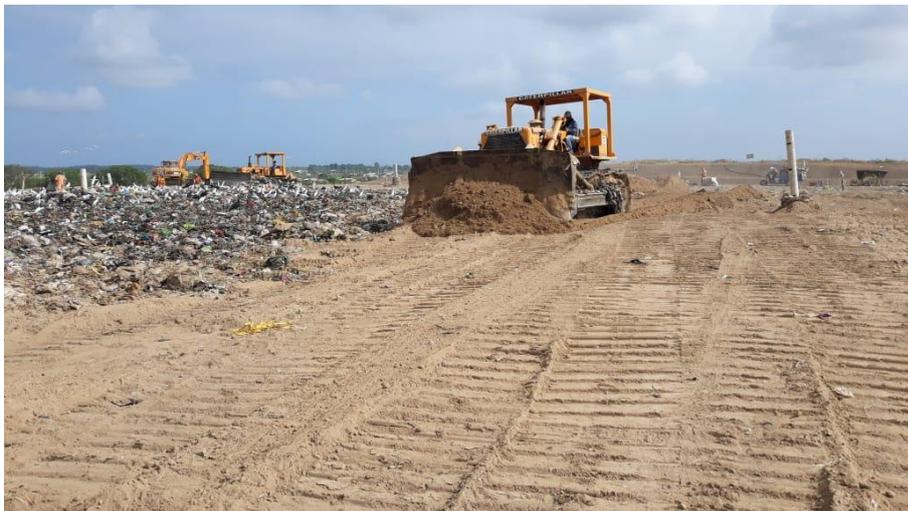
**Fotografía 2. 3** *Maquinaria cubriendo los RSU con una capa de tierra. Elaboración propia*
