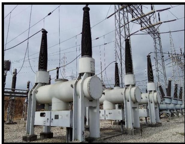
*Ilustración 18: Disyuntor de Potencia de 230 kV tanque muerto MITSUBISHI, fuente: CELEC EP TRANSELECTRIC SE Pascuales, Guayaquil – Ecuador.*
