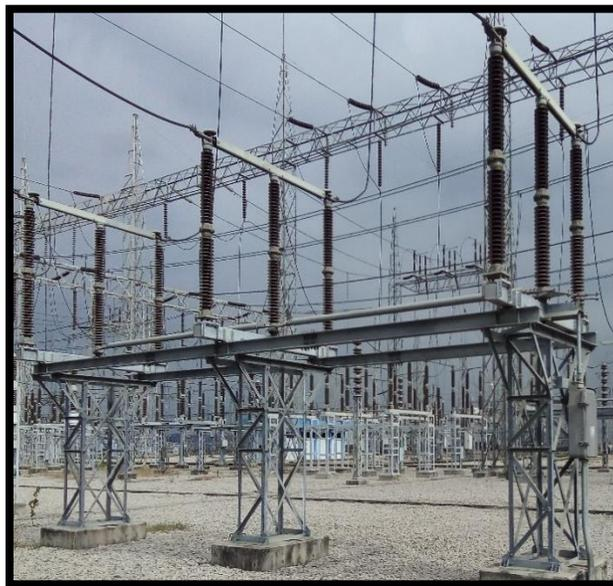
*Ilustración 23: Seccionador de potencia de 230 kV General Eléctrica Española, fuente: CELEC EP TRANSELECTRIC SE Pascuales, Guayaquil – Ecuador.*
