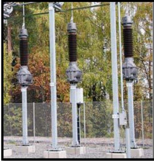
*Ilustración 144: Transformador de voltaje inductivo, fuente: (ABB, 2019).*
