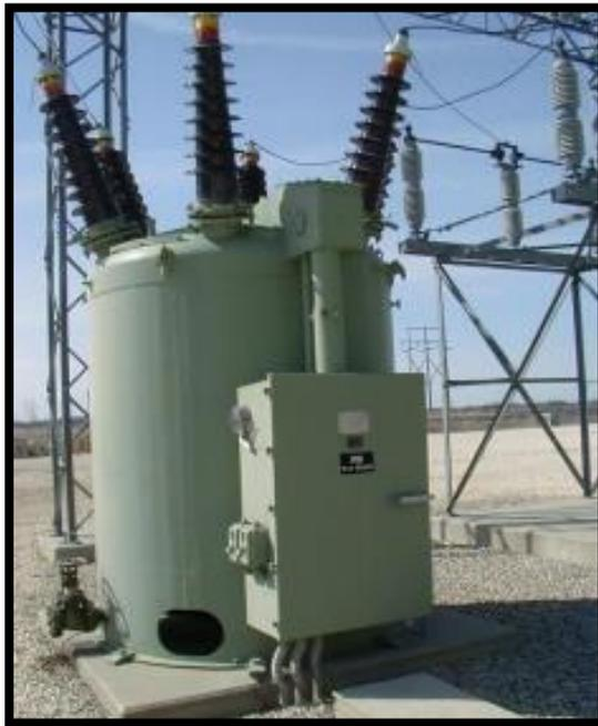
*Ilustración 16: Disyuntor de Potencia en aceite, alta tensión, exteriores, fuente: (Núñez Ramírez, 2015).*
