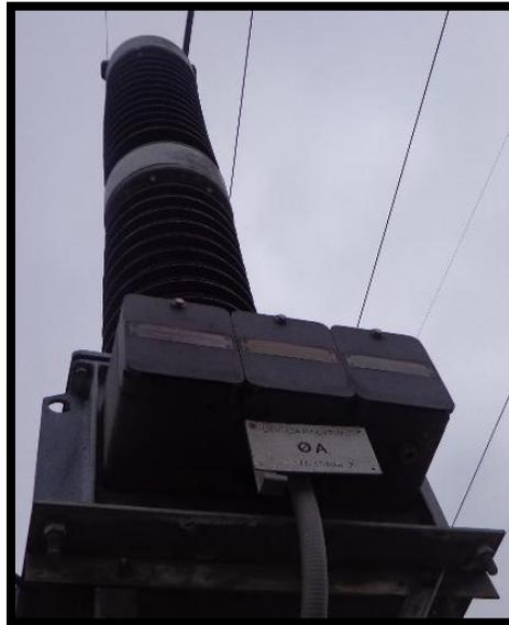
*Ilustración 26: Transformador de potencial de 245 kV ARTECHE, fuente: CELEC EP TRANSELECTRIC SE Pascuales, Guayaquil – Ecuador.*
