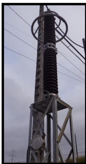
*Ilustración 20: Pararrayo de 192 kV ABB, fuente: CELEC EP TRANSELECTRIC SE Pascuales, Guayaquil – Ecuador.*
