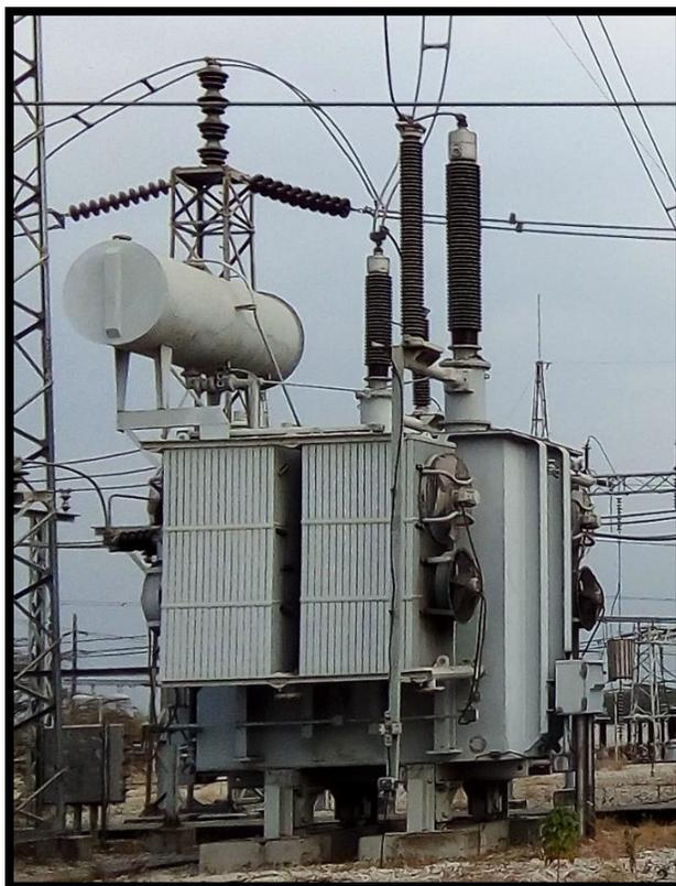
*Ilustración 13: Autotransformador de potencia de 230/138/13.8 kV con Capacidad de 125 MVA ABB, fuente: CELEC EP TRANSELECTRIC SE Pascuales, Guayaquil – Ecuador.*
