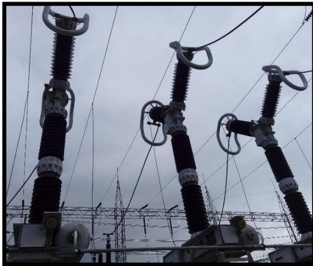
*Ilustración 19: Disyuntor de Potencia de 230 kV tanque vivo CENEMESA, fuente: CELEC EP TRANSELECTRIC SE Pascuales, Guayaquil – Ecuador.*
