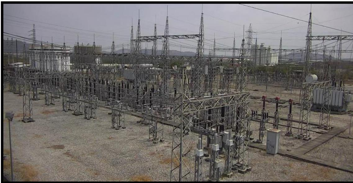
*Ilustración 9: SE Pascuales de 230/138/69 kV, fuente: CELEC EP TRANSELECTRIC SE Pascuales, Guayaquil – Ecuador.*
