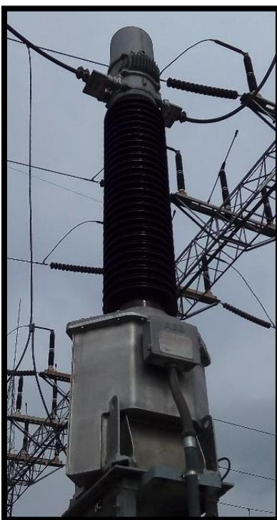
*Ilustración 24: Transformador de corriente de 100 kA ABB, fuente: CELEC EP TRANSELECTRIC SE Pascuales, Guayaquil – Ecuador.*
