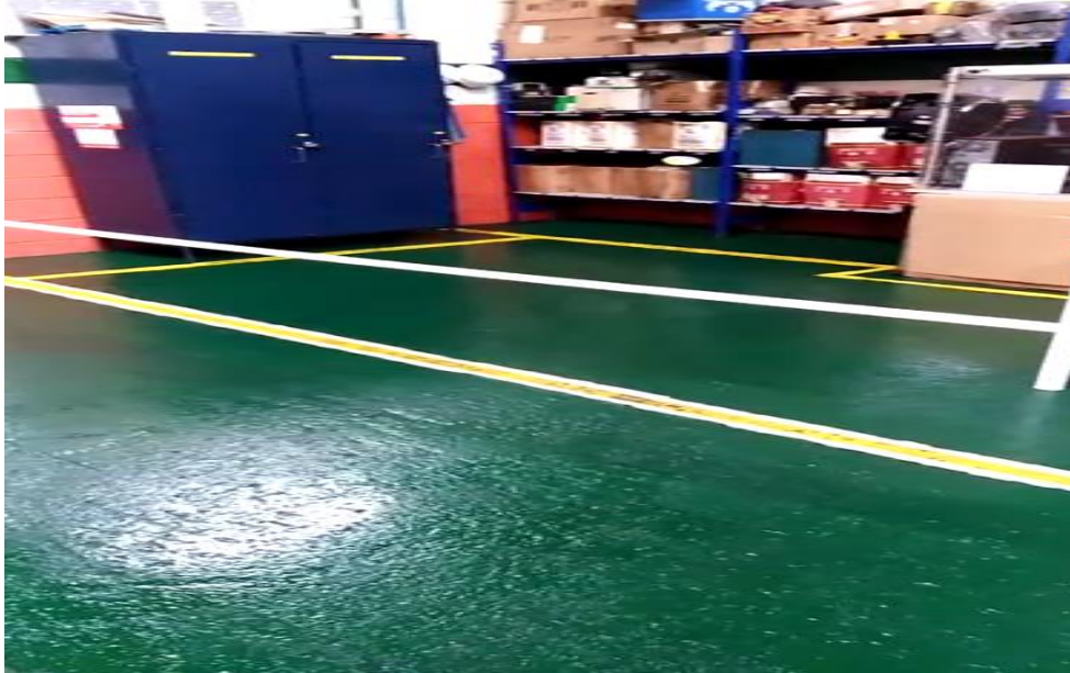
Figura 75.- Sector 4.- Área Eléctrica
