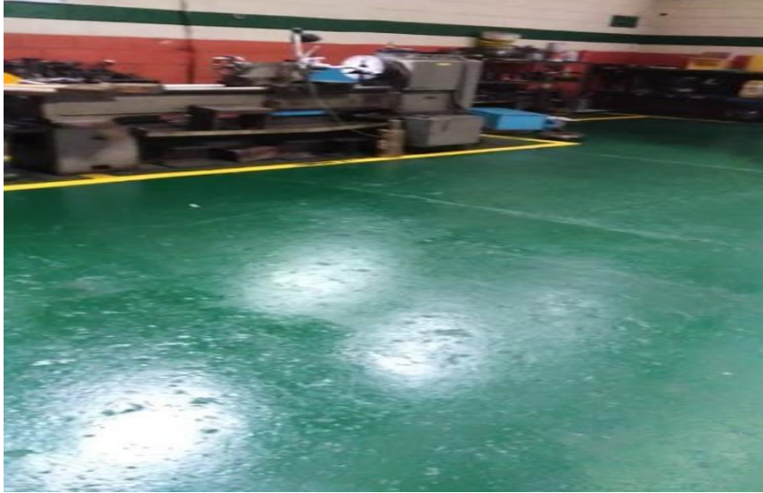
Figura 79.- Sector 2.- Área de Tornos
