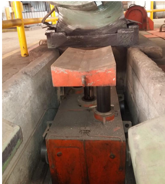
Figura 14. Carro de carga de bobinas. [Autores]
