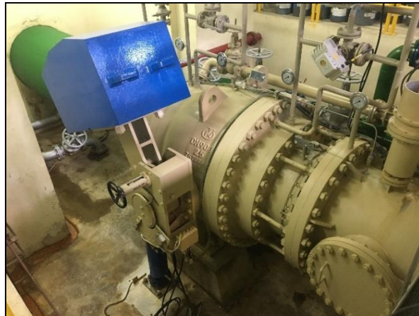
Figura 12. Válvula Esférica. Fuente: Autores.
