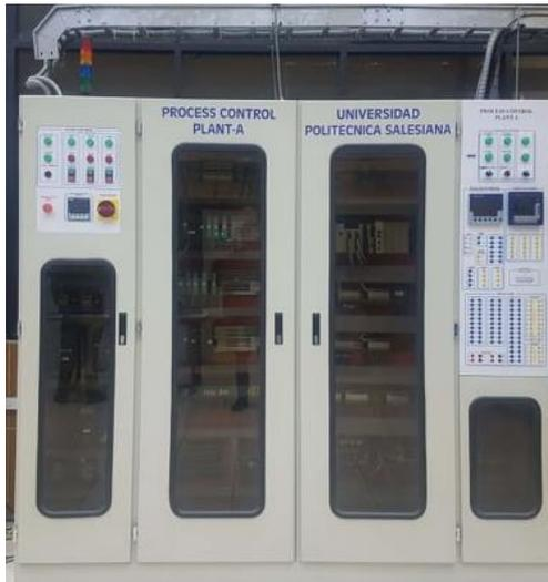
Figura 1.2 Tablero de control de la planta de control y procesos A
