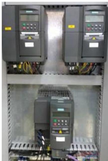
Figura 1.8 *Variadores de Frecuencia dentro de la planta de control de procesos A [8].*
