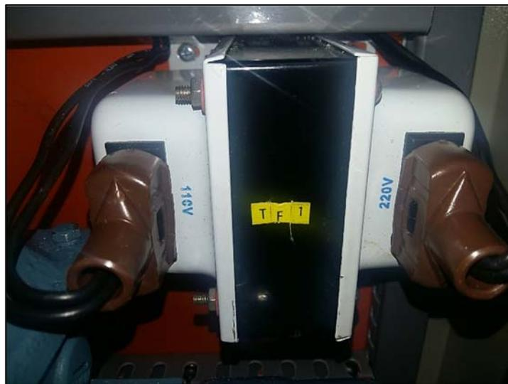
Figura 23. Transformador de mando que se utilizada en cada Maleta Didáctica.
