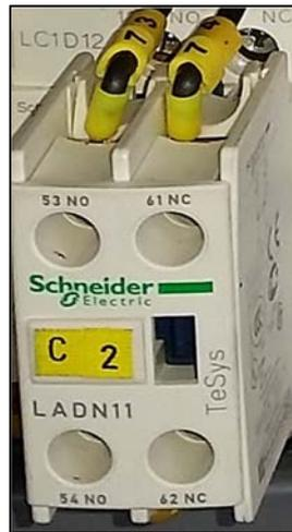
Figura 12. Esquema de un bloque de contactos auxiliares.
