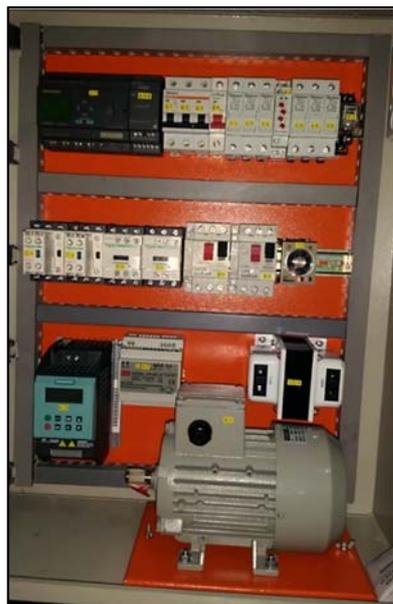
Figura 40. Plafón de elementos eléctricos y motor nuevo.
