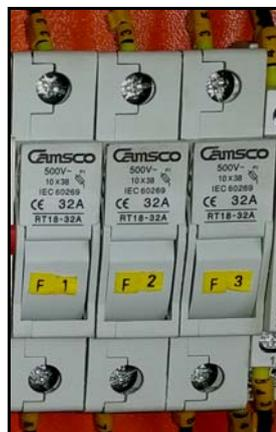
Figura 22. Fusible (protección de disparo rápido).
