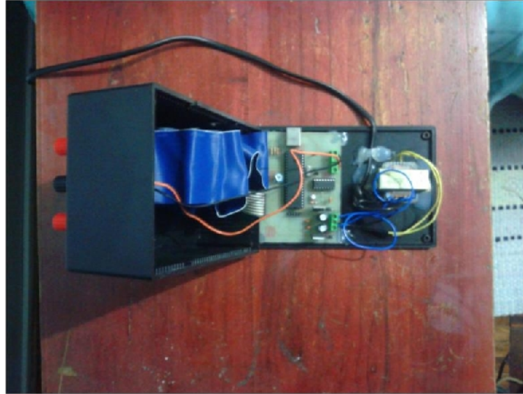
Figura 3 113: Circuito armado e instalado en la caja.
