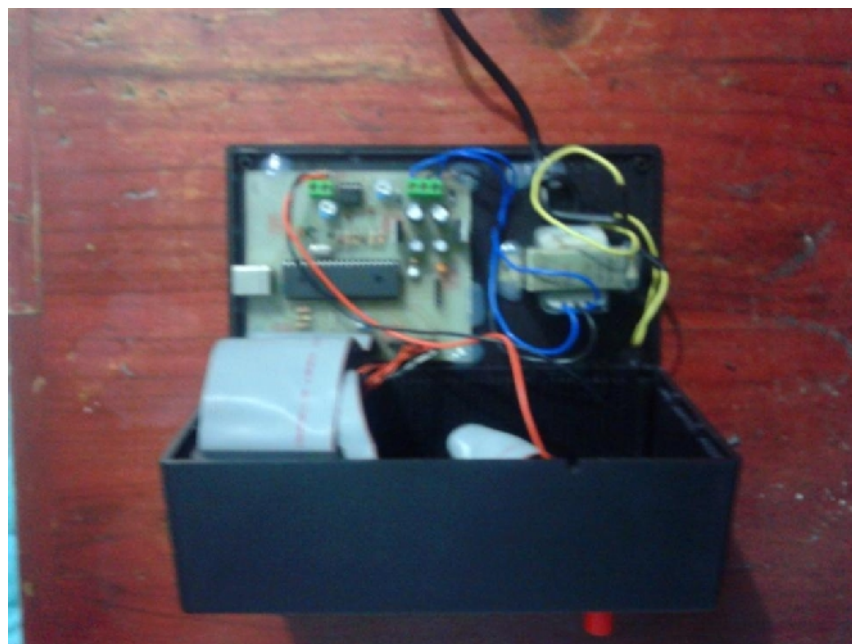
Figura 3.119: Circuito armado e instalado en la caja.
