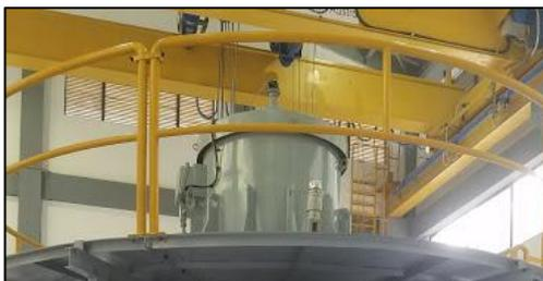
*Figura 5.2: Fotografía del Cojinete Superior de la Unidad 2 de Generación de la central Saymirín V.*
