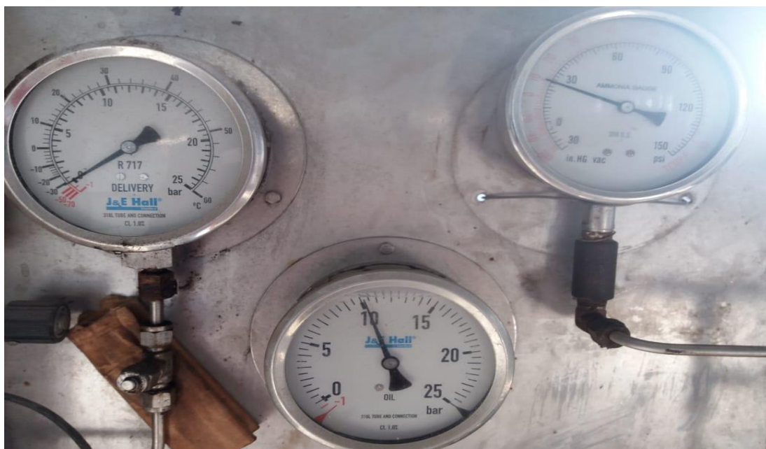
Figura 17: Presión de succión, aceite y descarga de los manómetros
