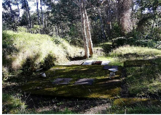
Figura 18. Tanque de oxidación del sector Guadalupe. Elaborado por: Autoras (2019).
