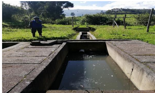
Figura 17. Tanque de oxidación del sector San Juan. Elaborado por: Autoras (2019).
