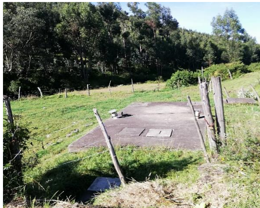
Figura 20. Tanque de oxidación del sector Fierro templado. Elaborado por: Autoras (2019).
