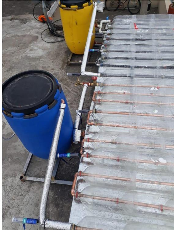
Conexión de tubos de recirculación al tanque.
