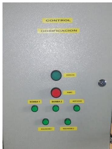
Figura 3.2: Tablero eléctrico de control y fuerza
