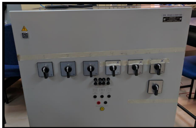
FIGURA 30: BANCO DE PRUEBAS RESISTIVO.
