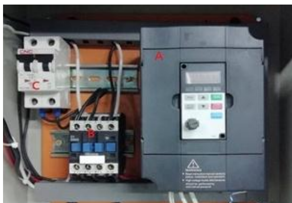
Fotografía del tablero de mando del motor de para el mando (Cárdenas Frank , 2019)
